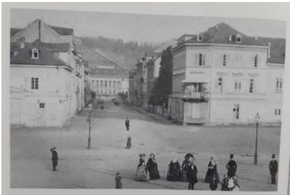
Schloßstraße ca. 1850, rechte Straßenseite die heutige Nr. 49, damals noch Nr. 1151 13 14 , unbebaut
